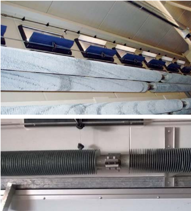
Фото 1. Приклад конструкції оребрених труб
